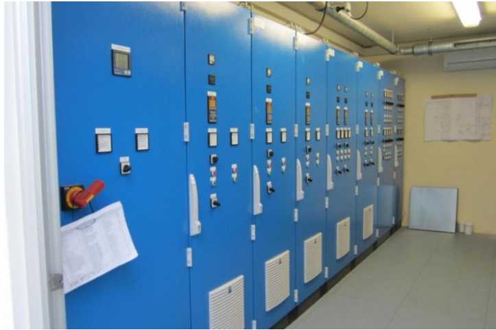
Niederspannungsschaltanlage RHB 14
